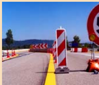
Signalisation de chantier
