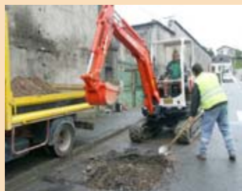
Travaux sur la voie publique
